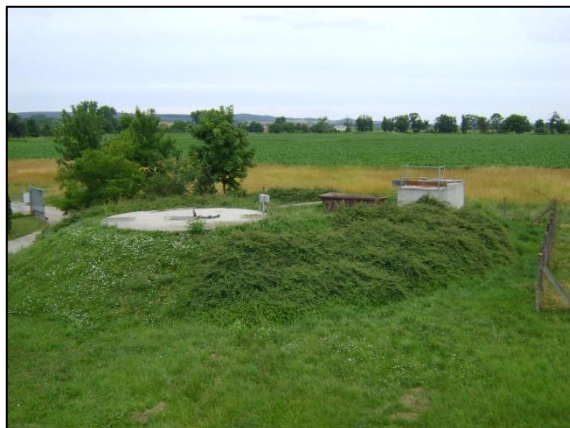
Szippantott szennyvíz fogadó és tároló
