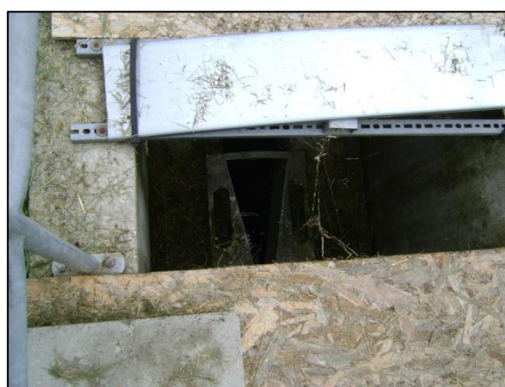
Parshall mérőcsatorna
