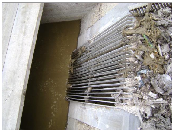
Szippantott szennyvíz kézi rács
