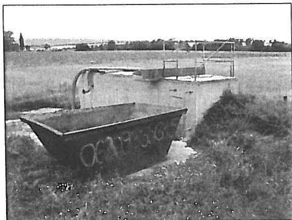
Szippantott szennyvíz fogadó akna
