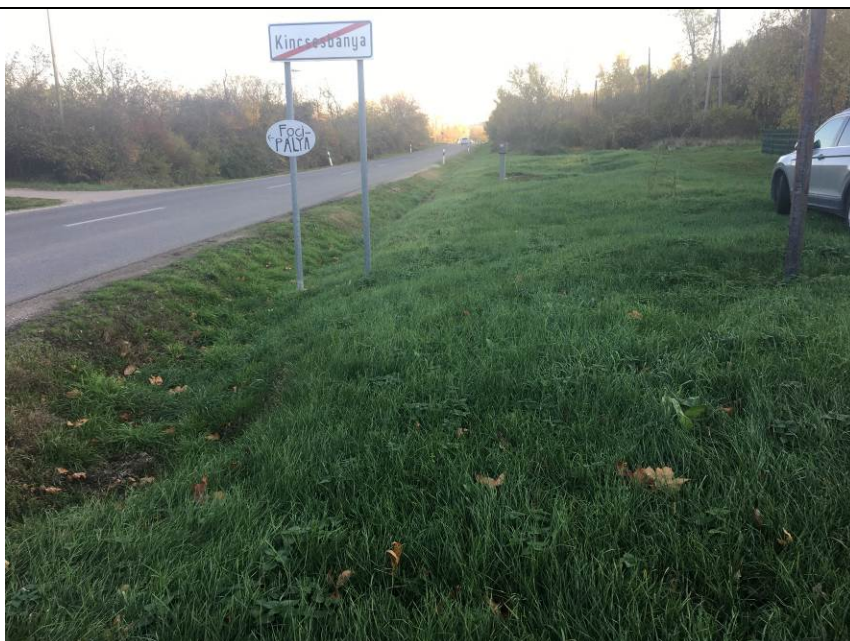
A 8202. jelű út melletti közúti árok
